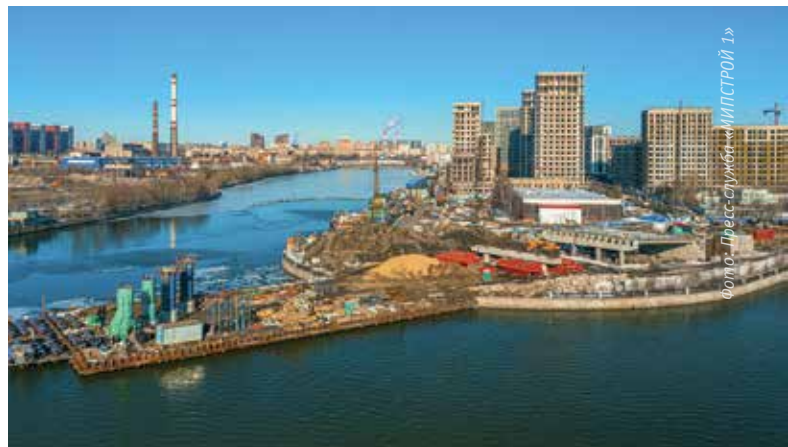
Строительство моста через затон Новинки
