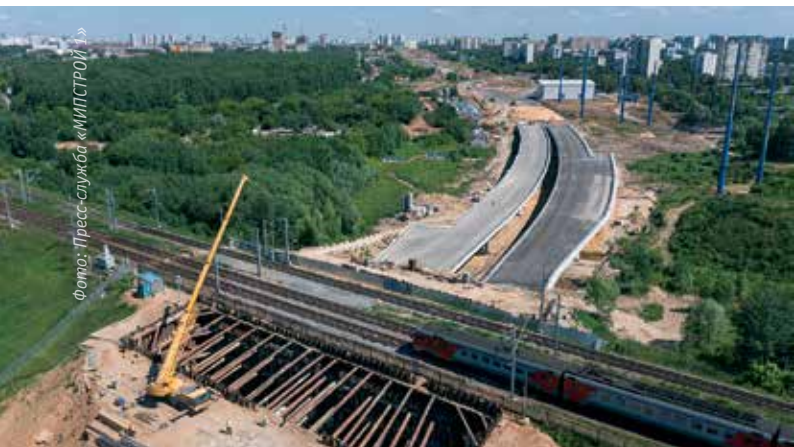
Строительство путепровода тоннельного типа на участке МСД
