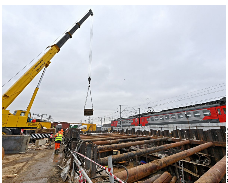
Строительство подземного путепровода на участке от Павелецкого направления МЖД до МКАД
